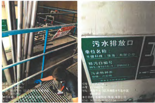
图3 含铬废水预处理口 (WS-41010-1) 采样照片
